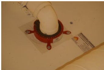
Figur 25. Brandtätning av rörgenomföring i brandcellsgräns. Foto: Erik Egardt
