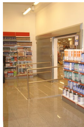
Figur 24. Brandtekniskt avskilt försäljningsutrymme. Foto: Erik Egardt
